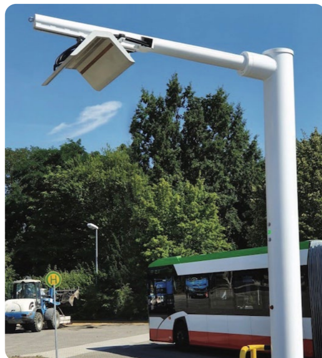
Pantografová stanica na konečnej zastávke v jednoduchšom industriálnom dizajne
